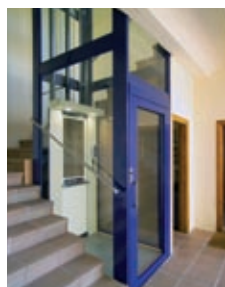
Ascensor elevador con estructura
